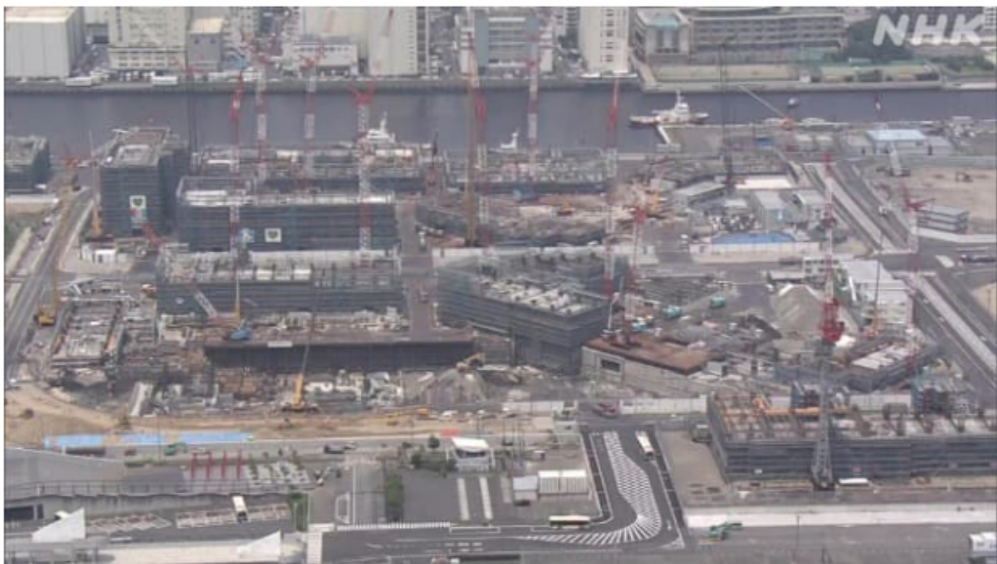
建設中の晴海フラッグ
